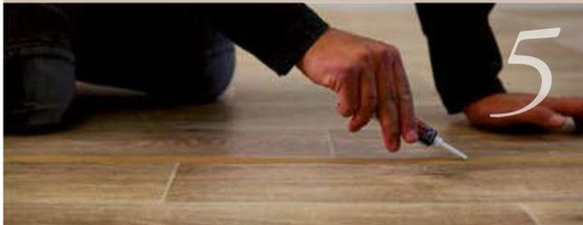
Introduire l'embout de la buse dans le joint et procéder à reculons en injectant lentement le liquide de soudure à froid jusqu'à ce qu'il déborde en surface sur le ruban adhésif papier
